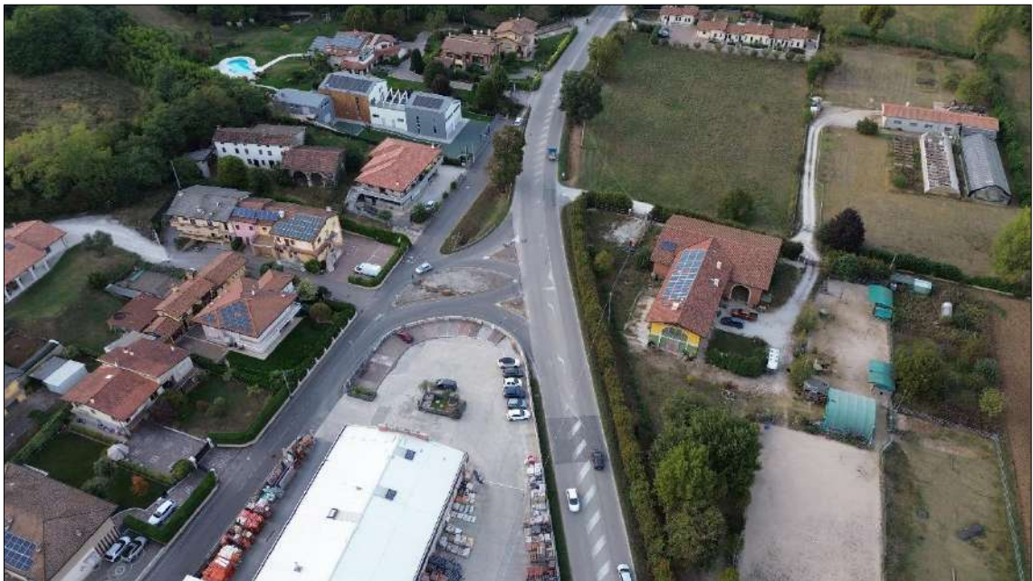
vista aerea da sud
